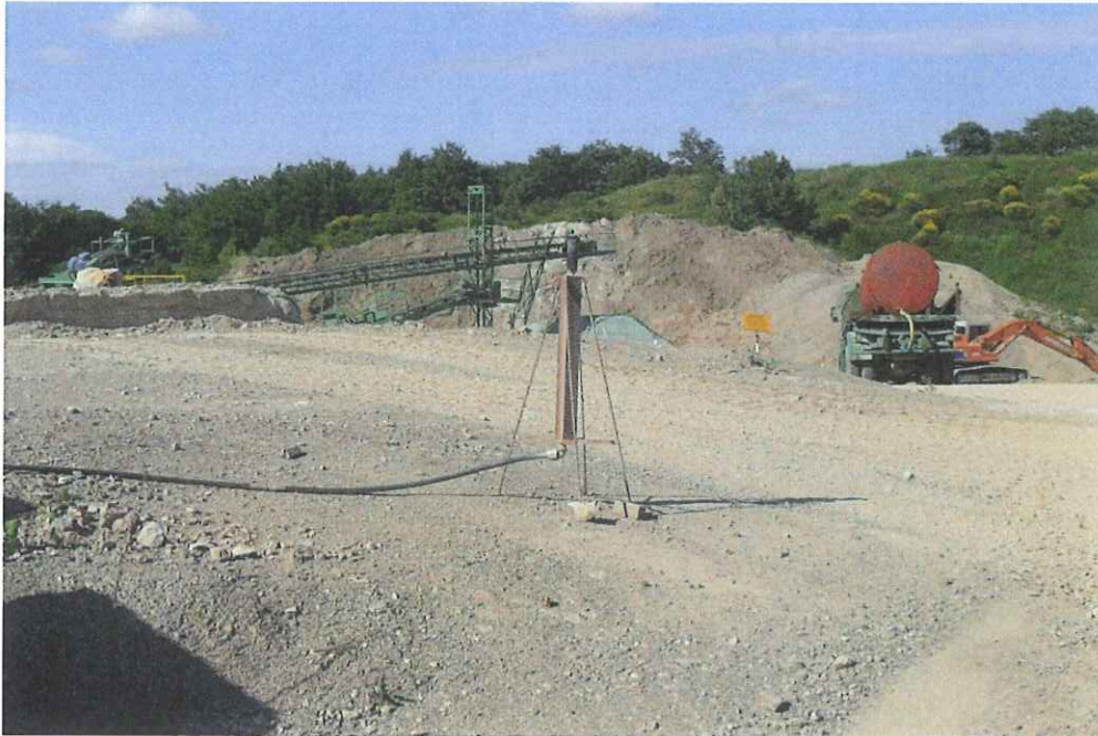
Impianto di irrigazione.
